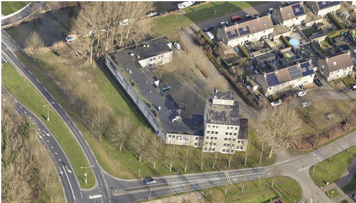
Afbeelding 1: Huidige situatie Kadegriend 1-21
